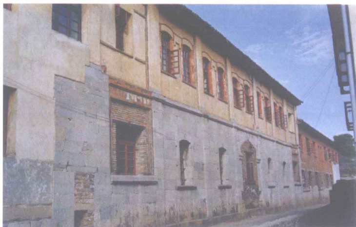
法式建筑正立面
