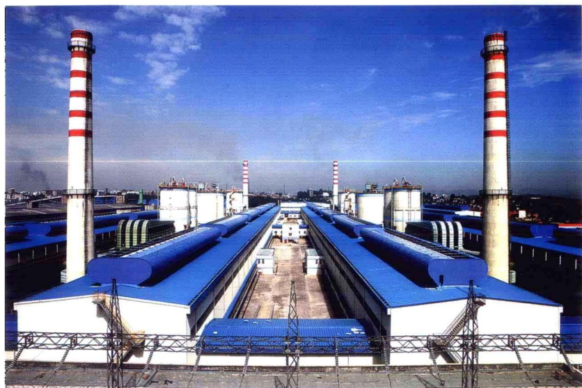
第四期电解厂房外景
