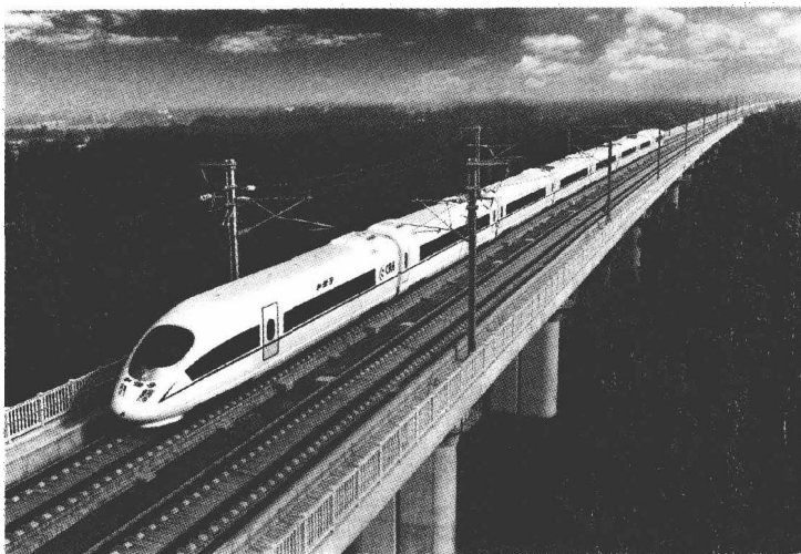
图 1.1 京津城际高速列车运行在高架桥上(见彩图)
