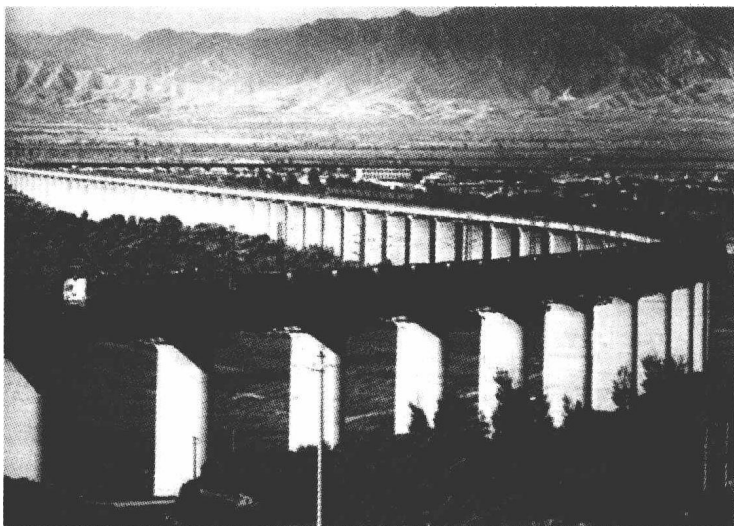
图 1.3 大秦铁路万吨重载列车运行在高架桥上(见彩图)
