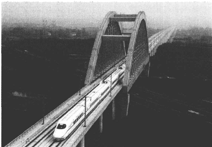
图 1.2 高速列车在武广客运专线汀泗河特大桥上(见彩图)
