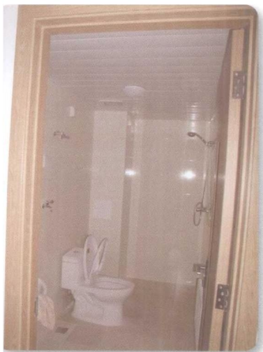
北京某公共租赁住房项目样板间卫生间实景图
