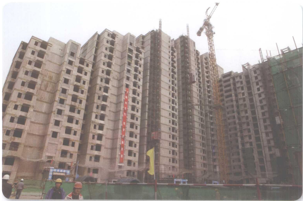
建筑面积 3.2 万平方米的北京远洋沁山水公共租赁住房项目施工现场
