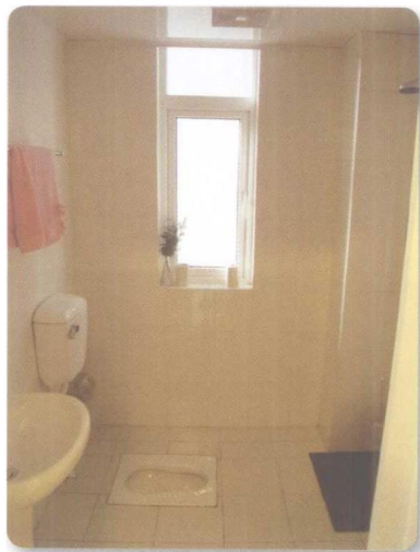
重庆民心佳苑公共租赁住房样板间卫生间实景图
