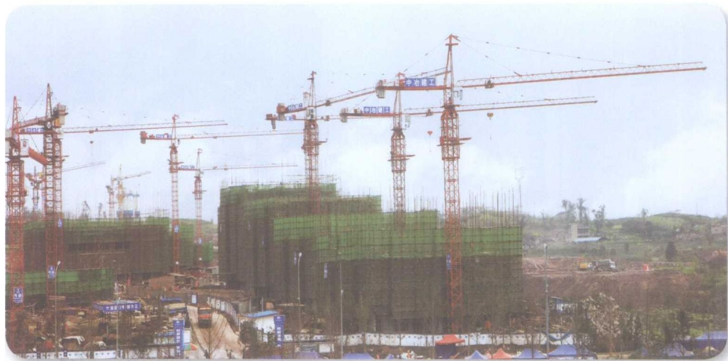
建筑面积 35 万平方米的重庆两江新区和合家园公共租赁住房项目施工现场
