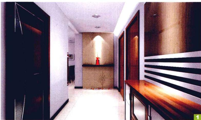
**1** 玄关背景墙为饰面板材质。施工做法为：先用大芯板作为底材，用钢钉固定在墙上，表面贴装饰饰面板，用汽钉固定，然后饰面板表面刷亮光清漆。整体造价大约在200元/平方米。
