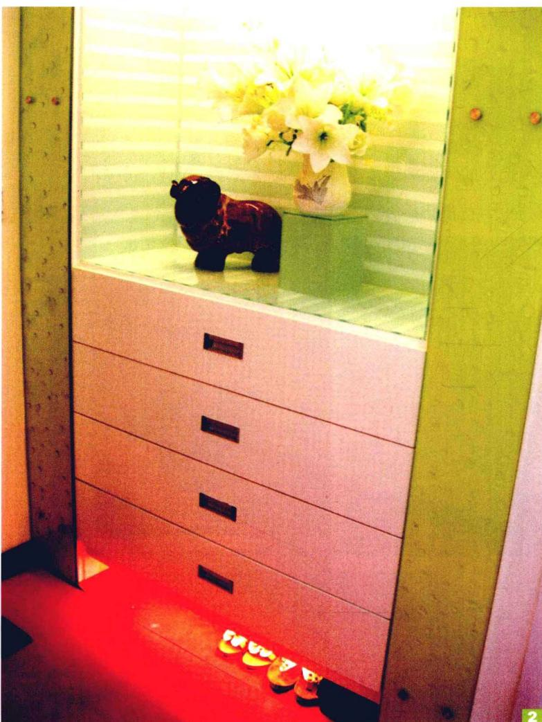
**2** 玄关柜为木器漆及装饰玻璃材质。施工做法为：先按照设计图纸用大芯板做出框架及结构，之后上装饰玻璃，内侧玻璃与柜体用玻璃胶粘结，外侧玻璃与柜体用专用连接件固定。最后柜体表面喷白色木器漆。整体造价大约在650元/平方米。
