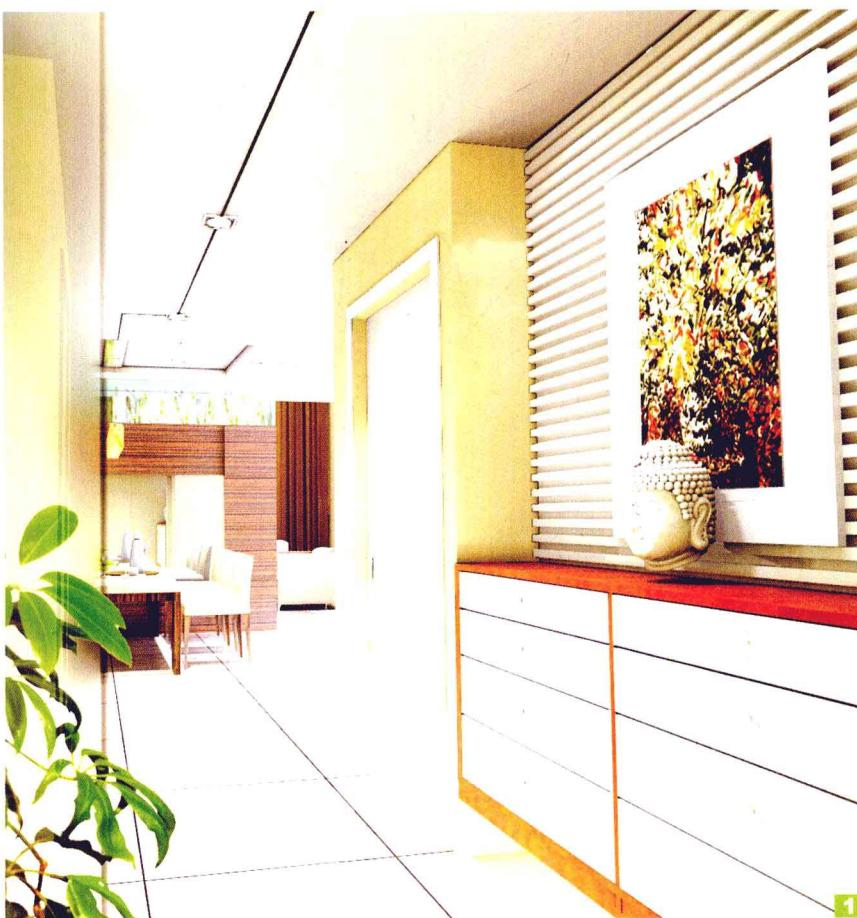
**1** 玄关背景墙为实木线条材质。施工做法为：先用大芯板作为底材，用钢钉固定在墙上，表面贴装实木线条，施工时要把实木线条按设计要求裁切成相应大小，用汽钉固定。最后喷白色木器漆。整体造价大约在350元/平方米。
