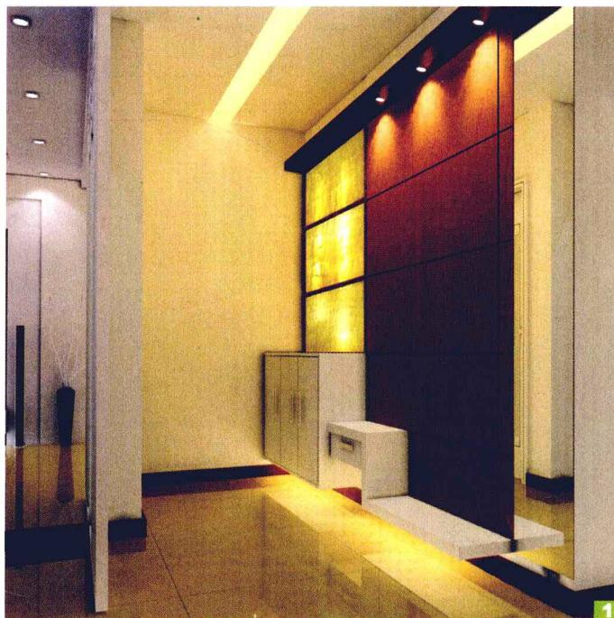
1 玄关背景墙为饰面板材质。施工做法为：先用大芯板作为底材，用钢钉固定在墙上，表面贴装饰饰面板，各饰面板块之间留5毫米缝隙，然后饰面板表面刷哑光清漆，最后用黑色勾缝剂勾缝。背景墙左侧为喷绘画，粘贴即可。整体造价大约在220元/平方米。
