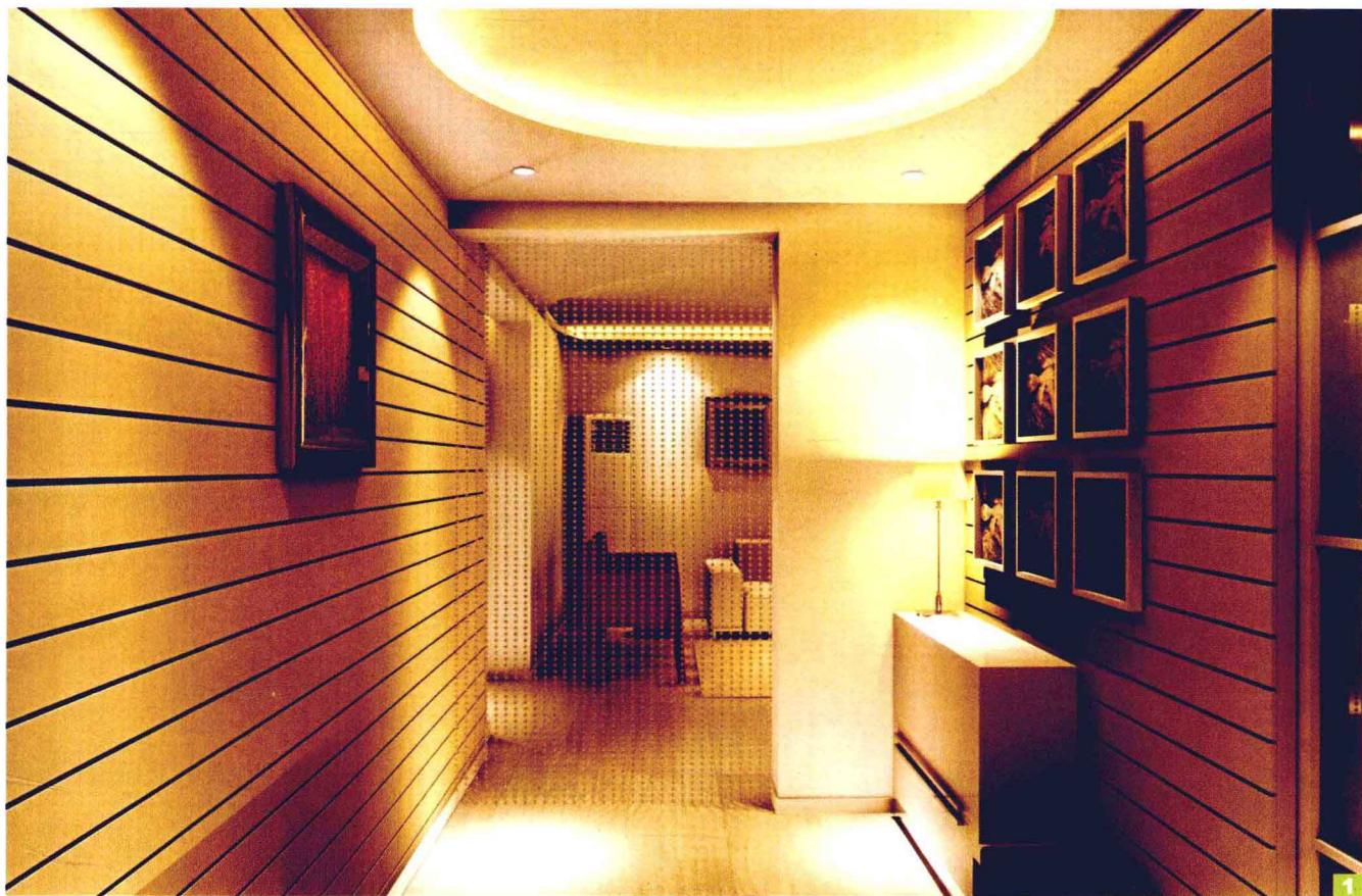
**1** 玄关墙面为木器漆材质。施工做法为：先用木龙骨做出框架。之后用大芯板作为底材，表面按设计图纸再次贴装大芯板。施工时要把大芯板按设计要求裁切成相应大小，用钢钉固定，各大芯板块之间留5毫米缝隙，然后用黑色勾缝剂勾缝，最后饰面板表面喷暖黄色木器漆。整体造价大约在300元/平方米。
