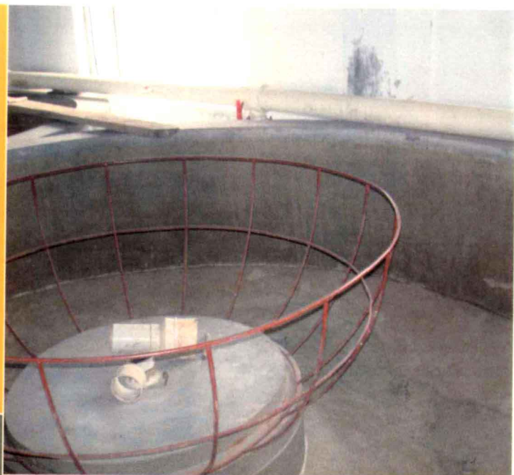
► 水泥池孵化环道
