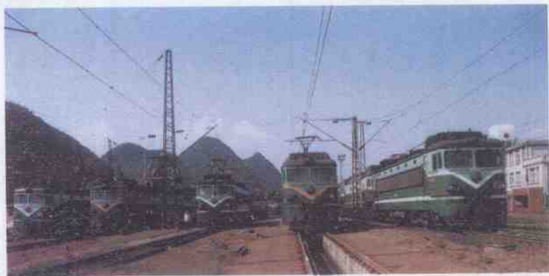
西南最大的电气化机务段在贵阳
