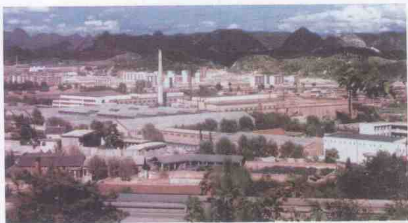
贵阳经济技术开发区工业园区一角
