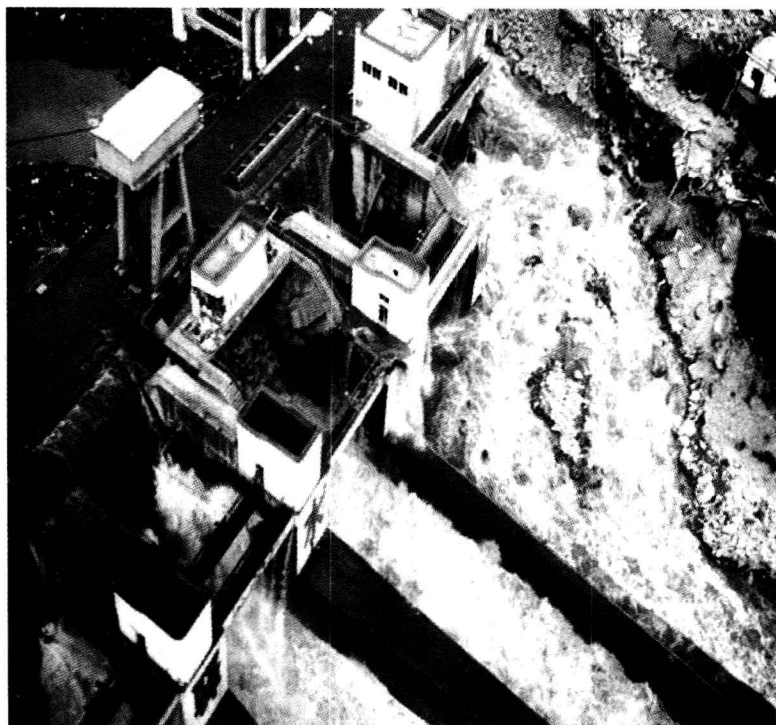
图 1-6 汶川地震发生后太平驿电站漫顶
