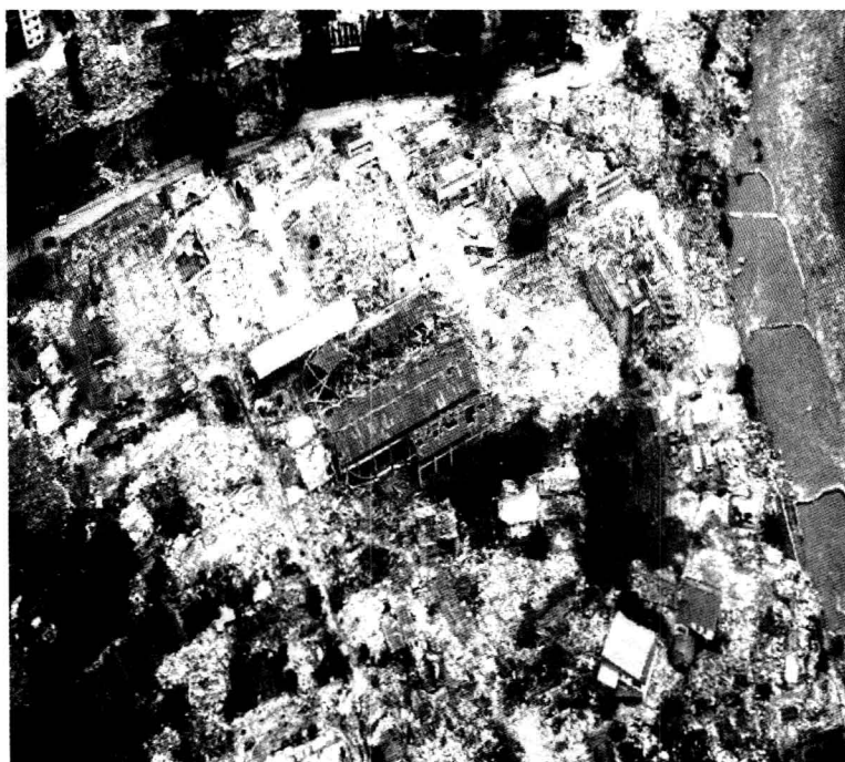
图 1-4 汶川地震后北川县城破坏情况
