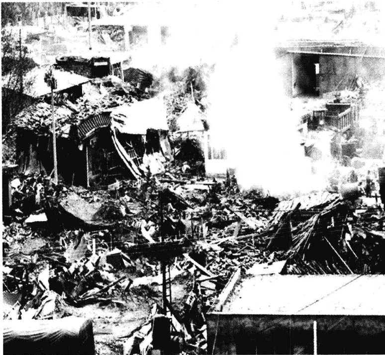
图 1-9 居民房屋成废墟
