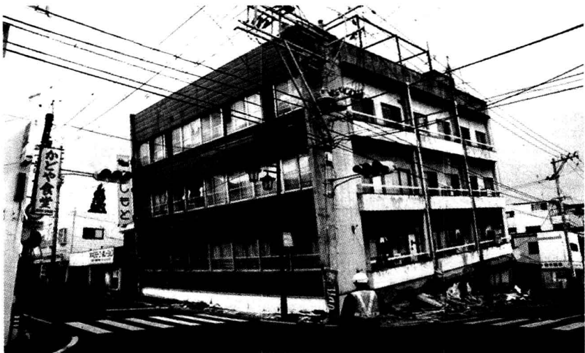
图1-10 日本2011年3月11日地震对建筑物的破坏
