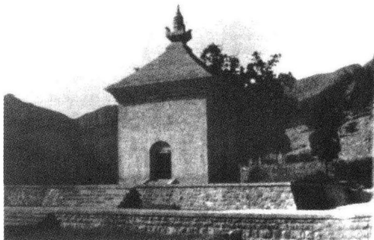
山东济南四门塔
