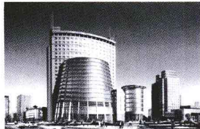
图1-4 某大型购物商场外观
