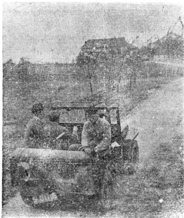
图 2 用沼气开动的吉普車正在作上坡試驗
