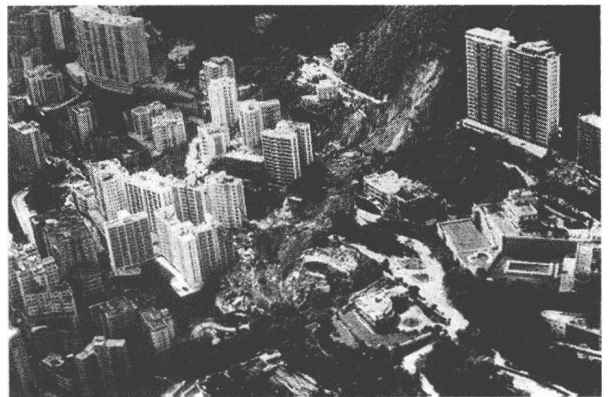
图0-5 香港宝城大厦滑坡现场情况
