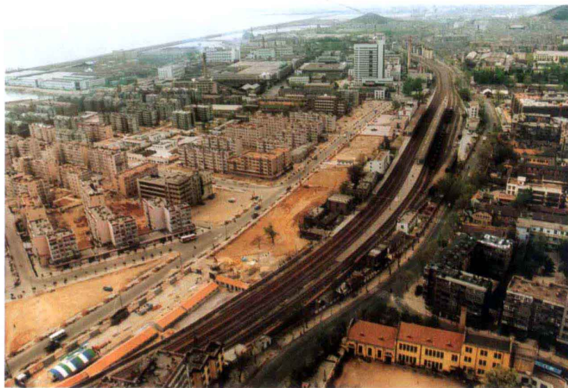
胶济铁路线沧口区间路段 ▶
