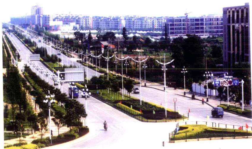
水电九局金阳分局承建的金阳新区第一条通车的城市道路——金阳大道
