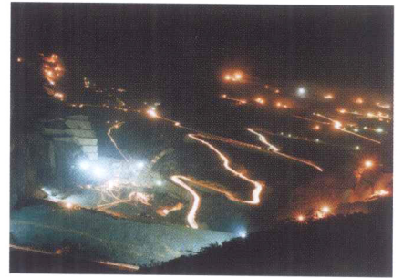
装机 60 万千瓦的洪家渡水电站 站建设工地夜景 (周秋亮 摄)
