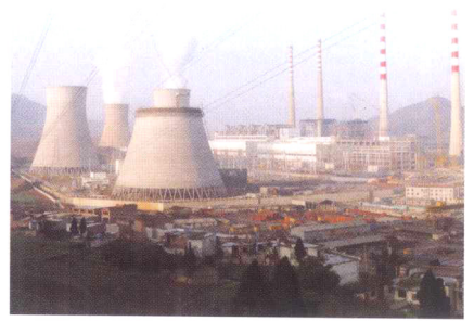
黔北发电厂一角
