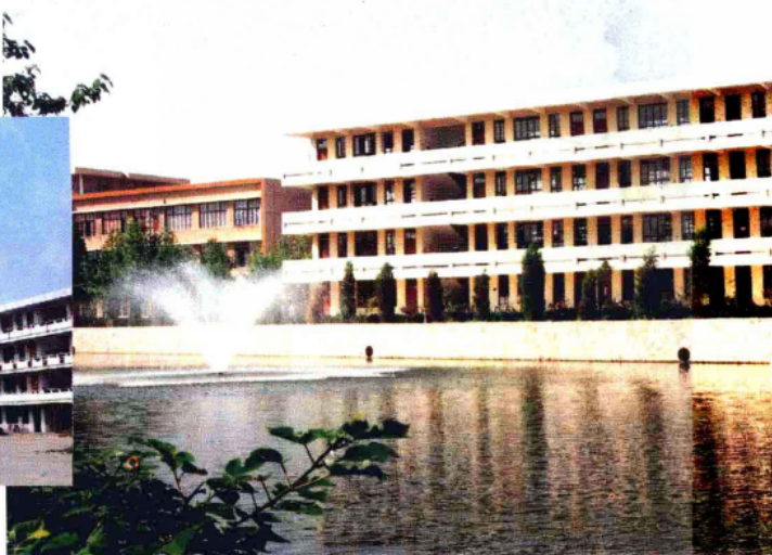
沭阳县中学教学楼
