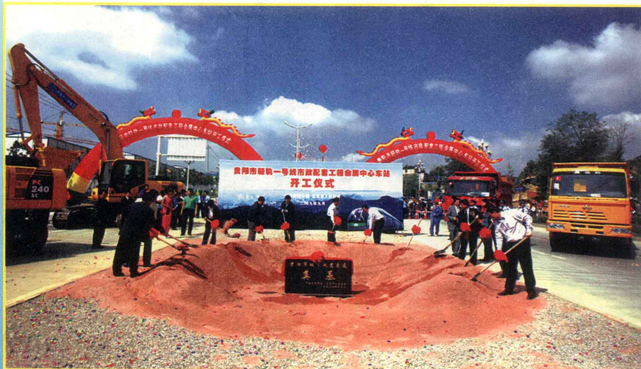
2009年9月29日，贵阳市轻轨一号线市政配套工程会展中心车站开工建设。
