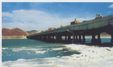
▲ 沈大高速公路普兰店海湾大桥
