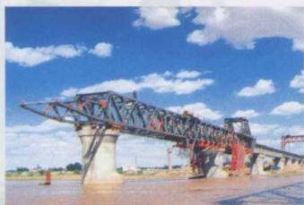
▲ 移动支架造桥机架设了两座黄河特大桥
