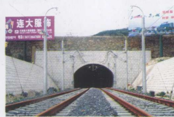
▲ 大连快轨椒金山隧道
