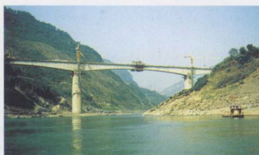
▲ 渝怀铁路黄草乌江特大桥，主跨168米，被誉为“中国铁路第一跨”
