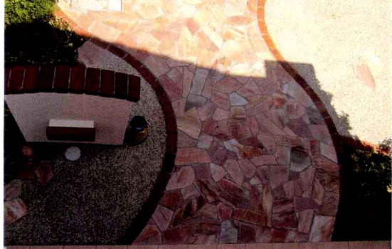
① 流畅的曲线通道,用自然石材按照不规则形状铺贴而成。
