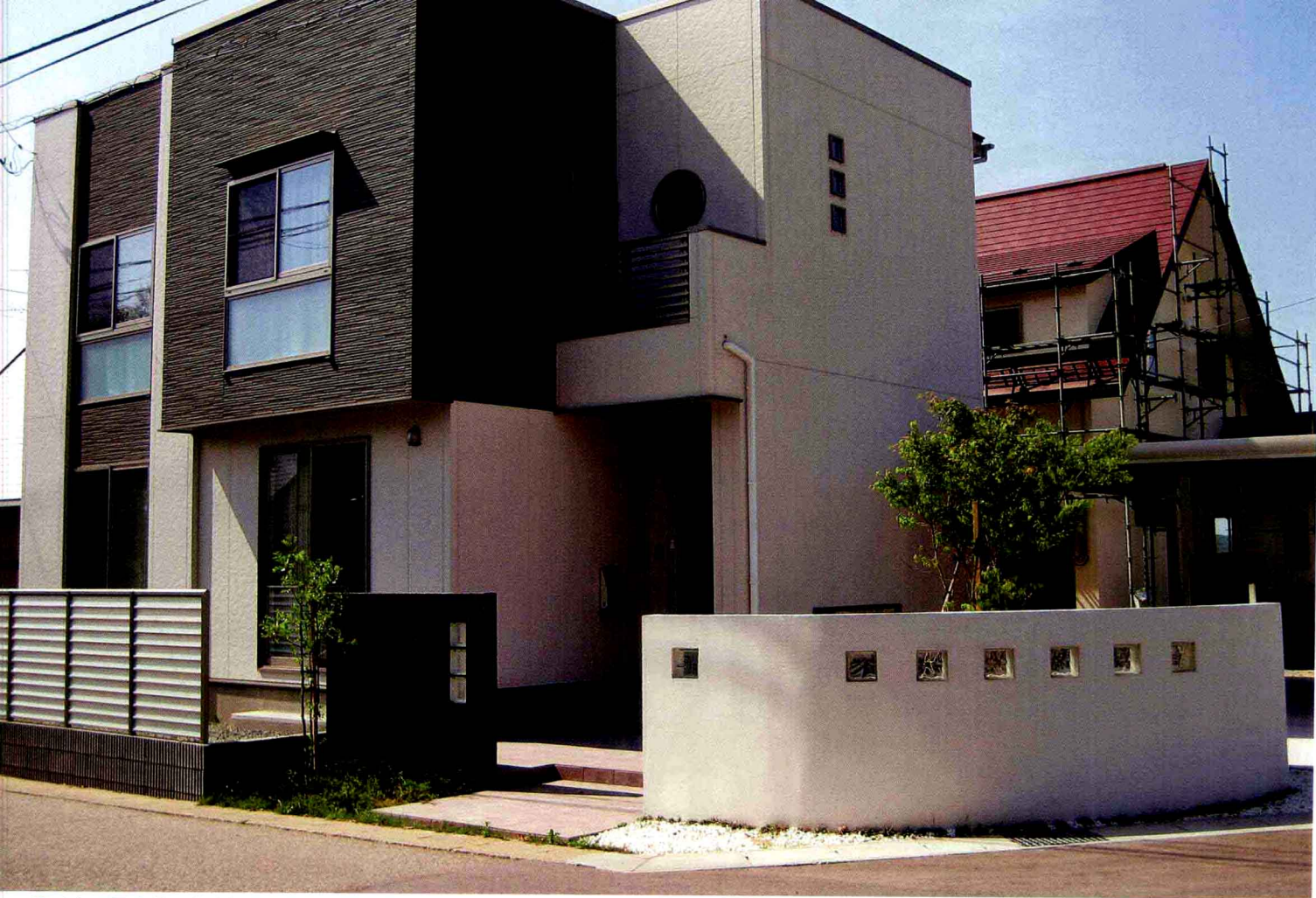
④ 大门周围全景。在大门周围设置涂墙装饰，白色柔和曲线的涂墙搭配明锐的直线形黑色墙，对比鲜明。
