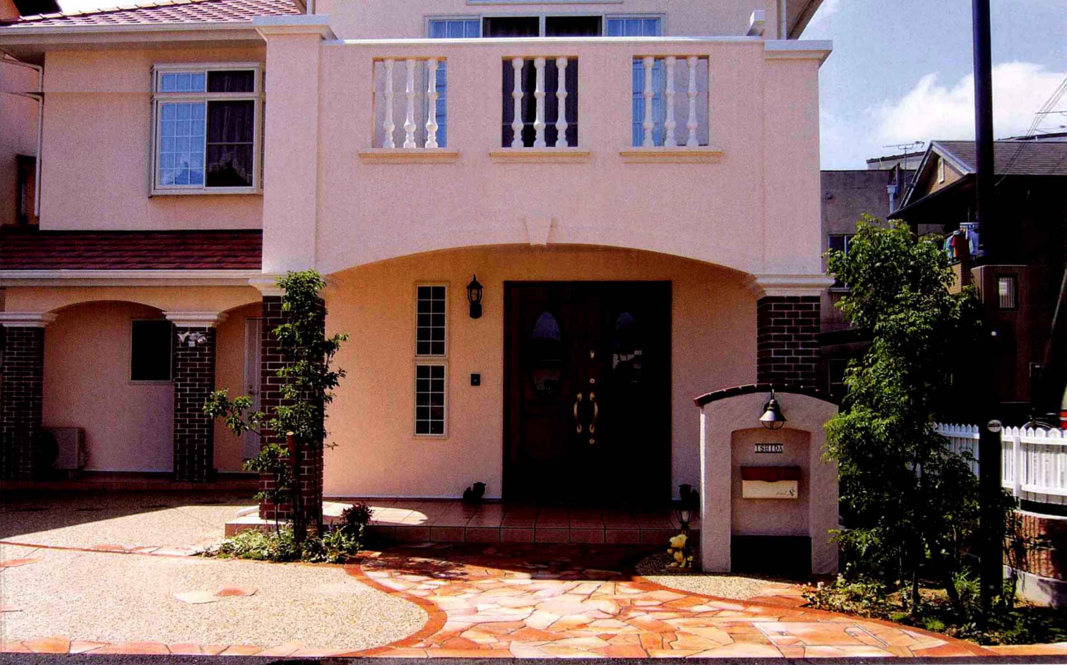
① 全景。完美衬托整个建筑形象的外观。
