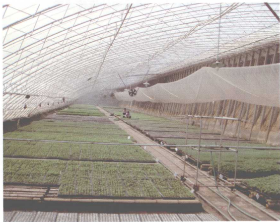
图 1-15 无立柱日光温室
