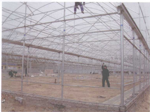
图1-17 建设中的连栋温室
