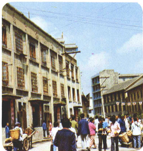
镇雄县农资日杂公司大楼
