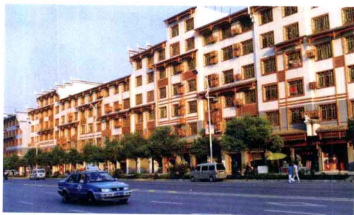
东太大道房屋立面改造一角
