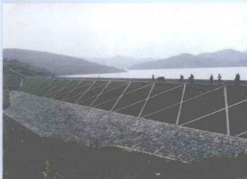
经过除险加固的黔西县水淹坝水库大坝
