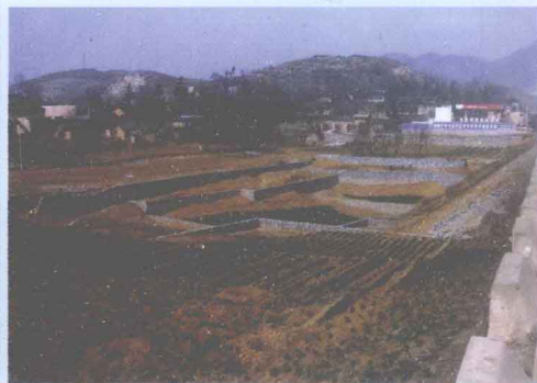
毕节市梨树镇正在施建中的水土保持坡改梯工程
