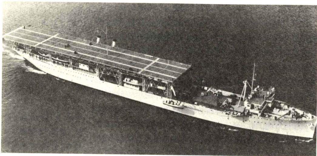
上图：1936年，“兰利”号的飞行甲板前部被拆除，改装成为水上飞机母舰。在其短暂的战斗生涯中，作为美国海军第一艘航空母舰，它一直承担着运输飞机的任务，直到1942年2月被日本轰炸机炸沉。
