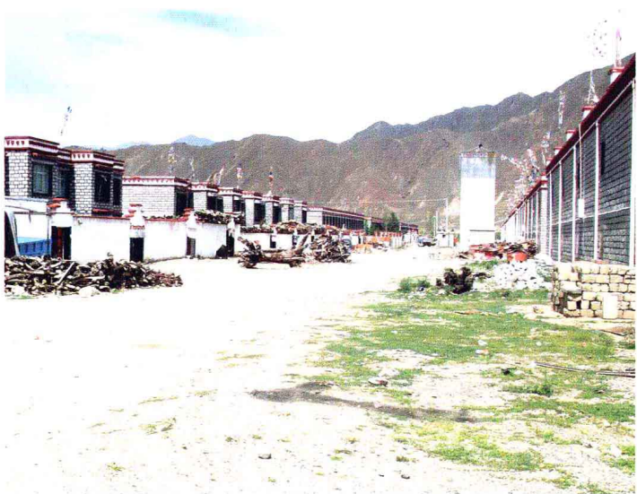
建设中的柳梧新村（2007年8月5日 陈朴摄）
