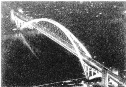
图 1-11 上海卢浦大桥
