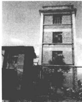
图 1-2 耿马糖厂蒸馏塔
