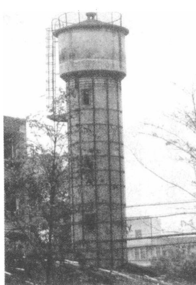
图 1-13 都江堰加固水塔完好
