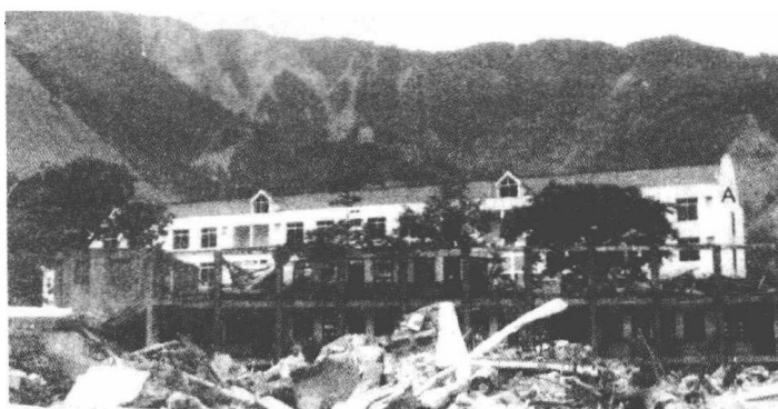
图 1-7 20 世纪 90 年代加固的 A 栋中等程度破坏，未加固的 B、C 栋倒塌（北川中学）
