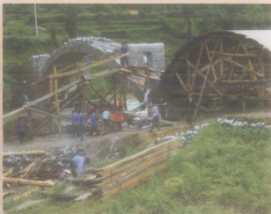
▲桥底村民修大桥 王黔辉 摄
