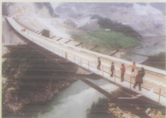
► 水电九局承建的构皮滩电站特大施工索道桥 王黔辉 摄
