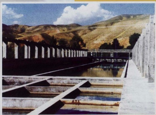
新源县自来水厂平流反应沉淀池
