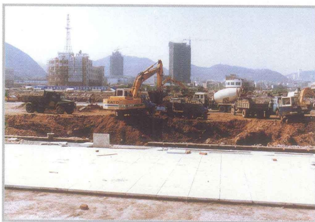
兴义广场正 在紧张施工。
