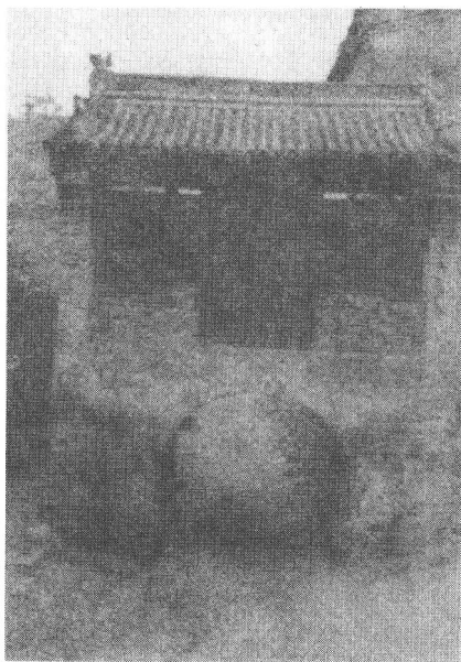
山西临县克虎镇戏台之神楼
