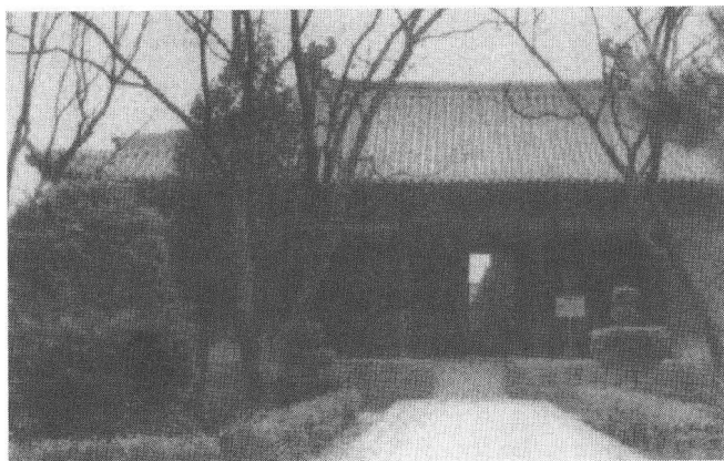
山西芮城永乐宫龙虎殿元代过路戏台
