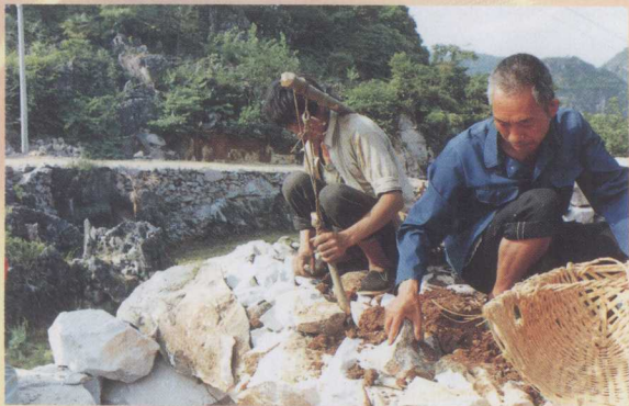
大关村党支部书记何元亮和群众在一起造田。先平整田的底层,铺上碎石,再填泥土
