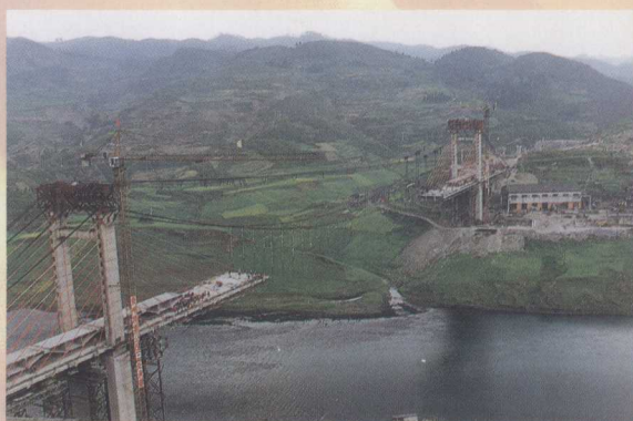
国家“八五”重点项目贵(阳)遵(义)高等级公路正在加紧施工,图为建设中的采用吊拉组合施工的乌江公路大桥(廖 柳 摄)
