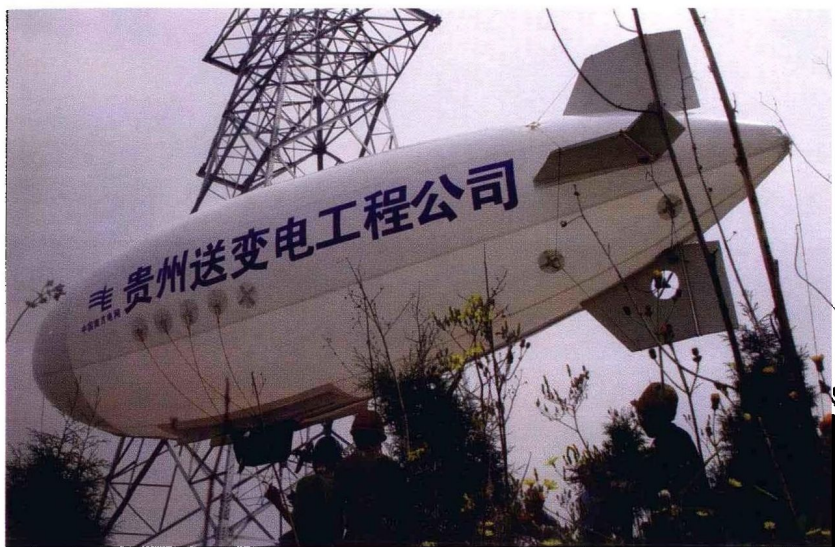
2005年4月21日，公司在重庆220千伏玉花线首次遥控飞艇施放放线引绳成功，图为遥控飞艇牵引着引绳徐徐升空
