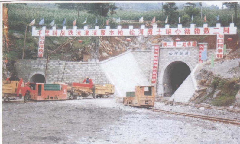
◁ 水柏铁路施工现场
