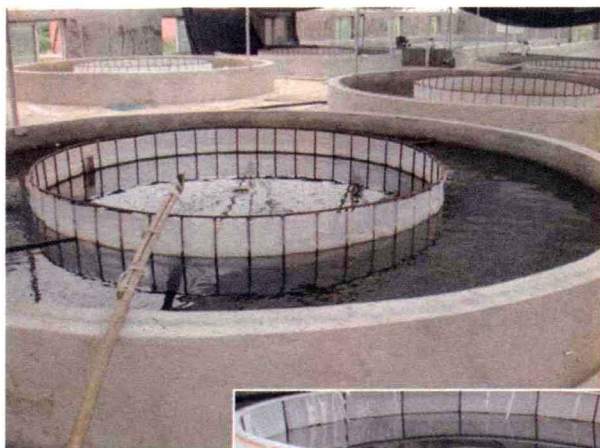
水泥池孵化环道
