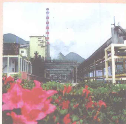
水钢煤焦化分公司
