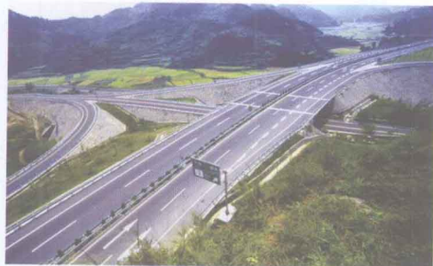
凯麻高速公路下司出口
