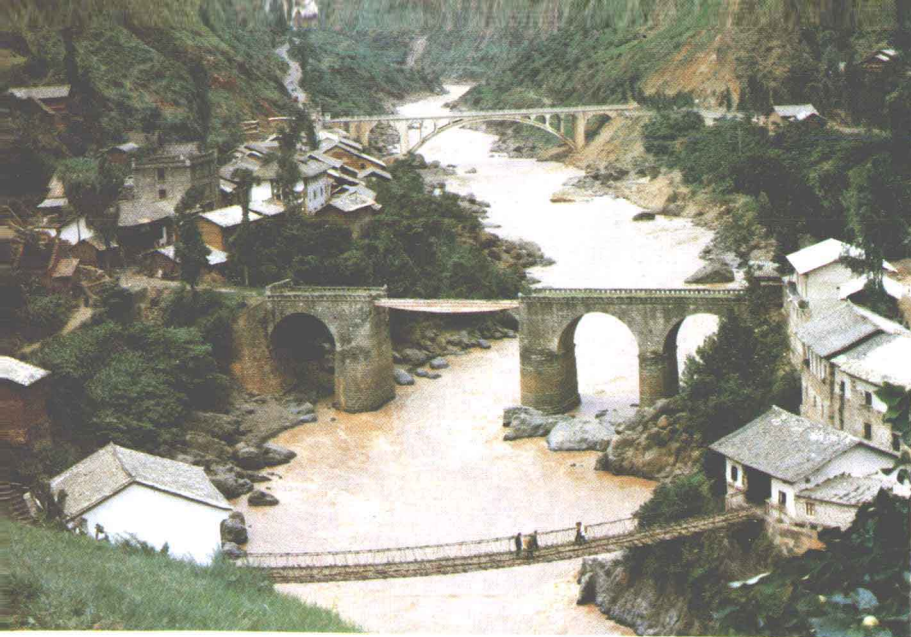
▲ 江底三桥 鲁甸县大水井区江底镇，隔牛栏江与会泽县相望，自古是交通要道。原有人马吊桥，后修了公路桥，近年又新建双曲拱公路桥。一镇建三桥，反映了交通运输的巨大变化。
