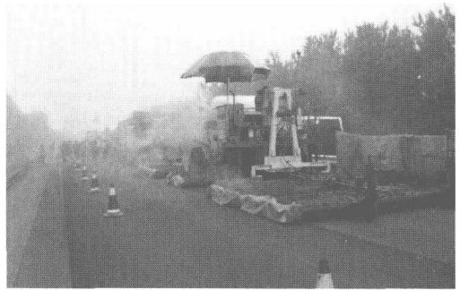
图 1-6 就地热再生的施工现场
