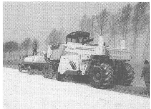
图 1-8 全深式就地冷再生的施工
