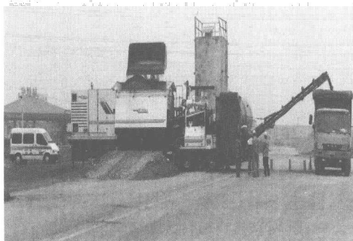
图 1-9 厂拌冷再生混合料的拌制
