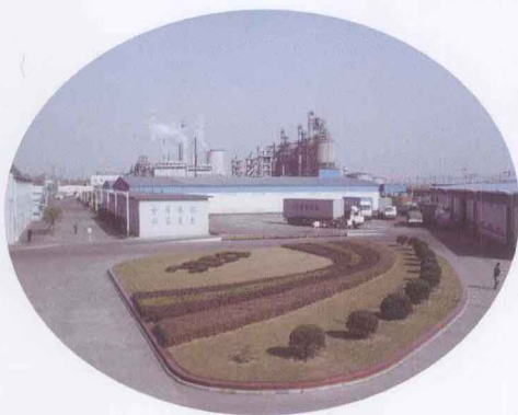
中橡公司俯视图
