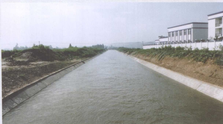
通济堰总干渠
