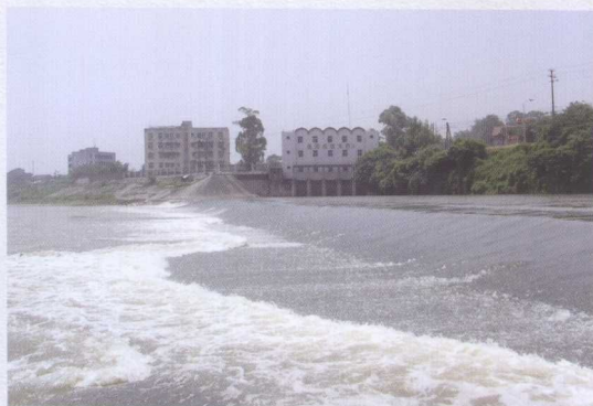
改造前的通济堰引水拦河坝
