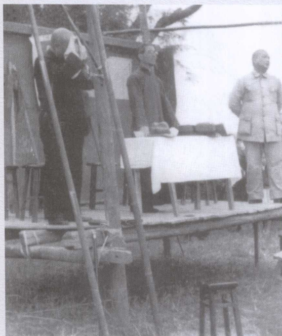
1939年通济堰眉山醴泉堰支渠新修 开工典礼
