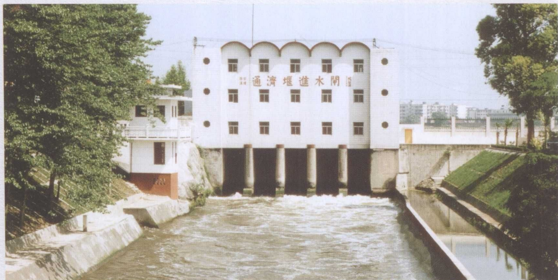
通济堰总干渠进水闸
