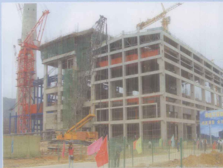
建设中的大方火电厂
