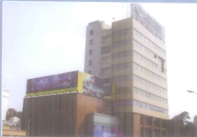
毕节分公司通信大楼
