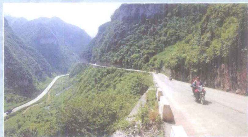
通县公路改造完成
