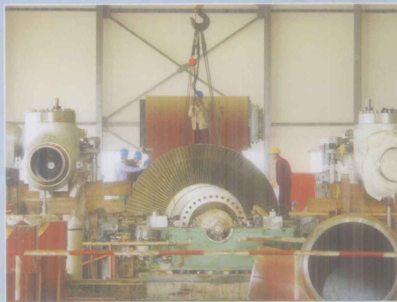
黔西火电厂1号机组安装调试
