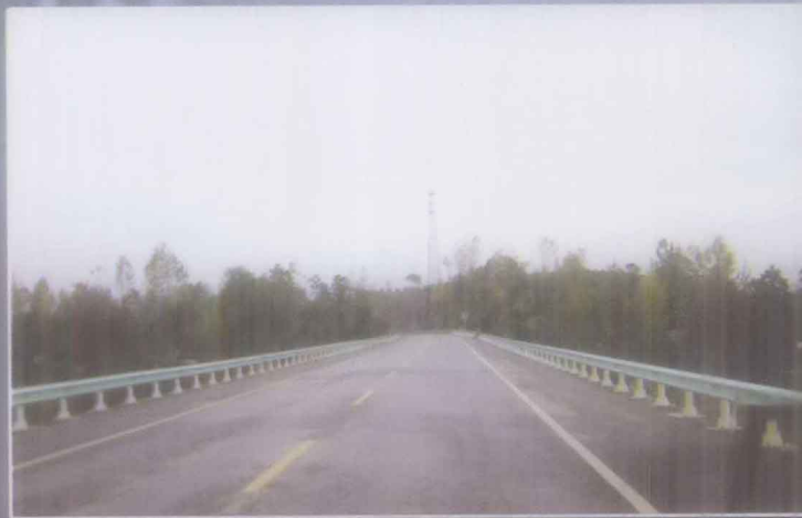
移动通信基站
