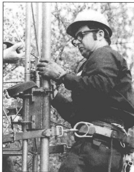
图1-1 Bill Lowry (W1VV) 使用在天线塔上工作所必需的高质量安全带。安全带应当用大号的钢环作为皮带扣。安全带后部的皮带环应当可以很方便地携带工具。（图片由K1WA提供）
