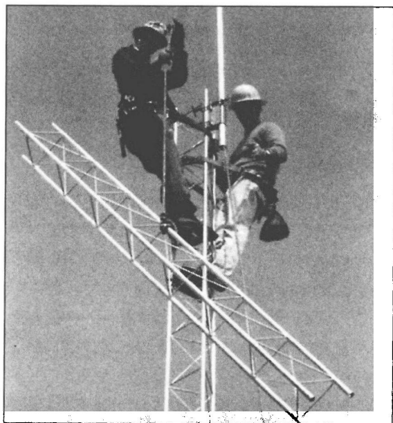
图1-5 当使用起重吊杆将每一个组件吊装至合适的位置时,天线塔零件的组装就变得非常简单了。注意到两个攀塔者的安全带都在电杆的下面扣牢,因此可以防止皮带从顶端的部件上滑落。(图片由K1WA提供)
