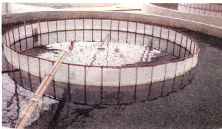
水泥池孵化环道
