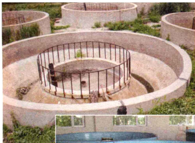
水泥池孵化环道
