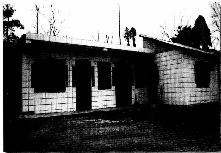
拆除茅草房后修建的新居
