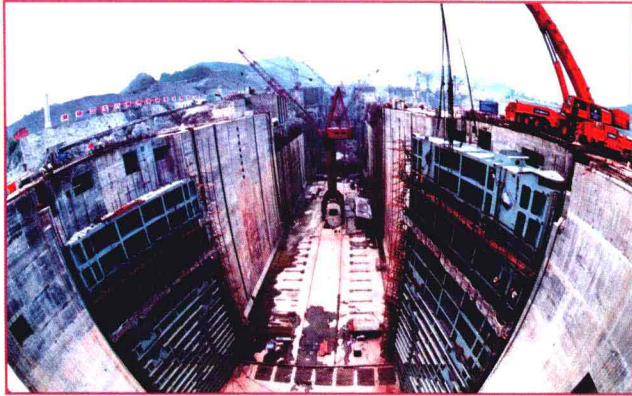
三峡工程永久船闸
