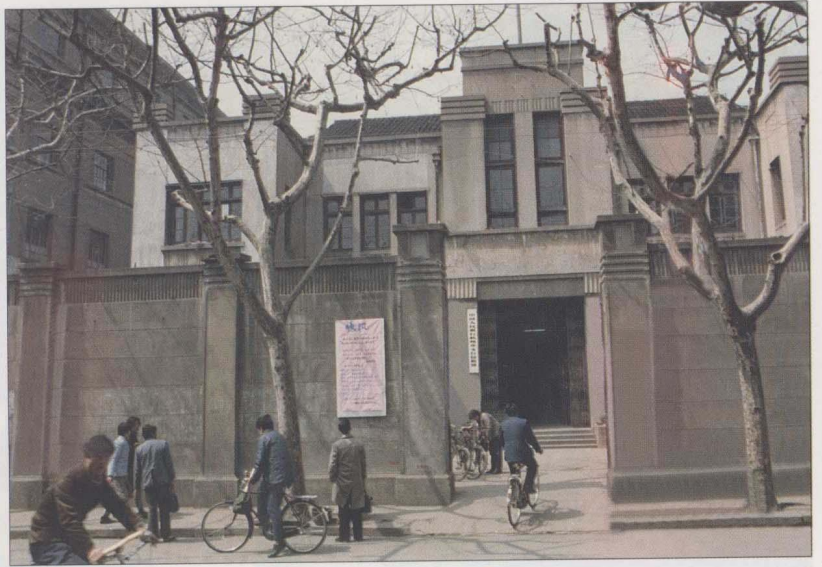
中国人民银行杭州市支行，地址：中山中路273号(原为民国时期中国银行杭州分行行址)
