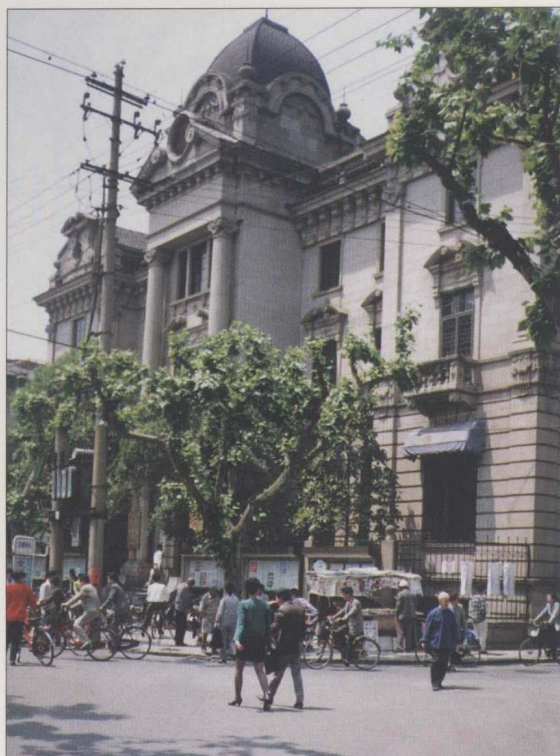
中国工商银行杭州市分行营业部 地址：羊坝头(原为民国时期浙 江兴业银行行址)
