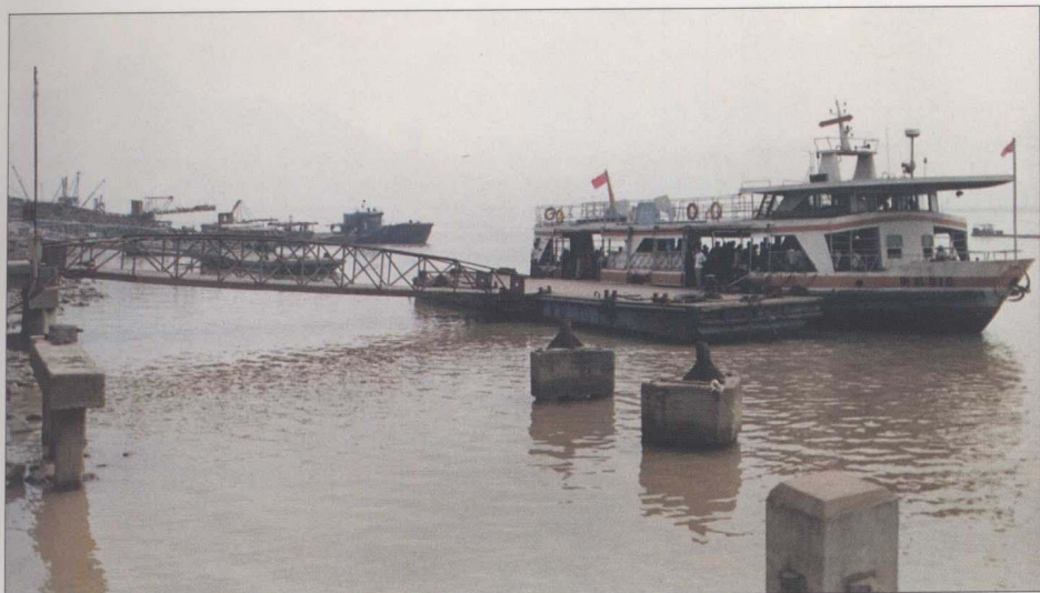
浙江第一码头渡船栈桥
