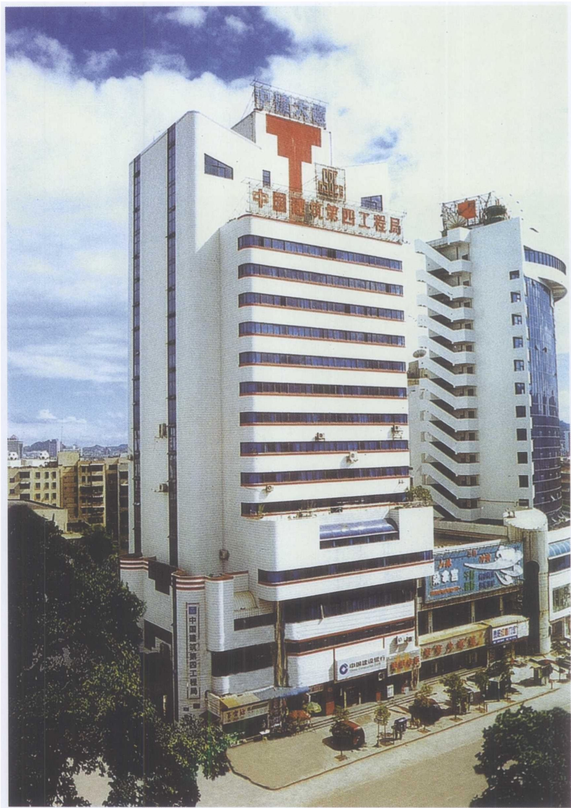
▲ 中建四局总部办公楼
