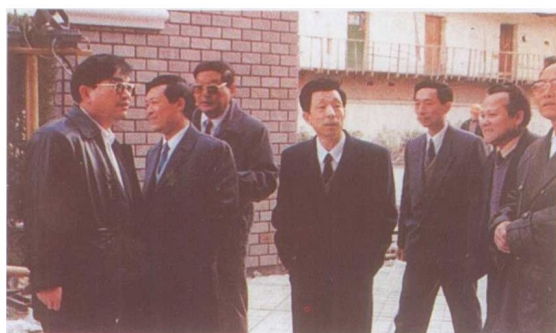
▲ 1990年11月中建总公司马挺贵总经理和张耀宗副总经理等同志视察上海罗马花园工程
