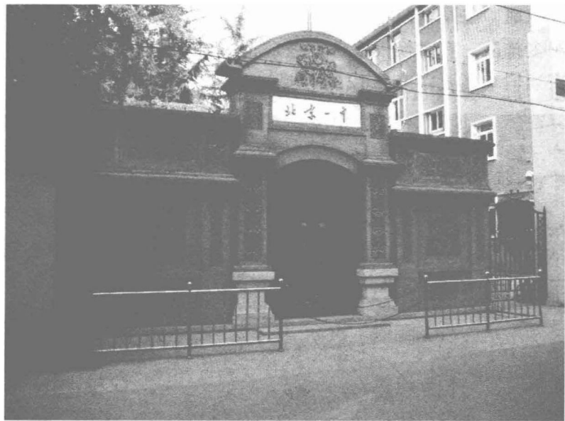
北京一中（原八旗子弟学校）的门楼
