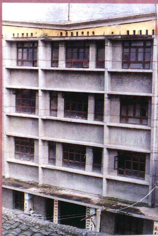
石阡县龙塘供销社营业大楼
