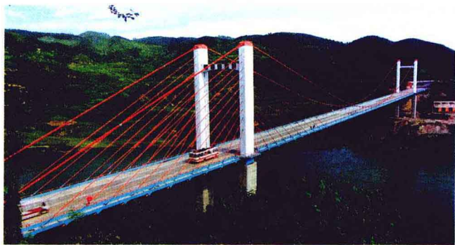
► 贵遵高等级 公路乌江大桥
