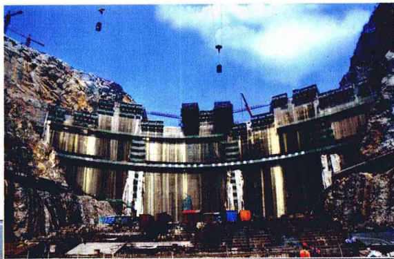
建设中的余庆县构皮滩电站 ▶
